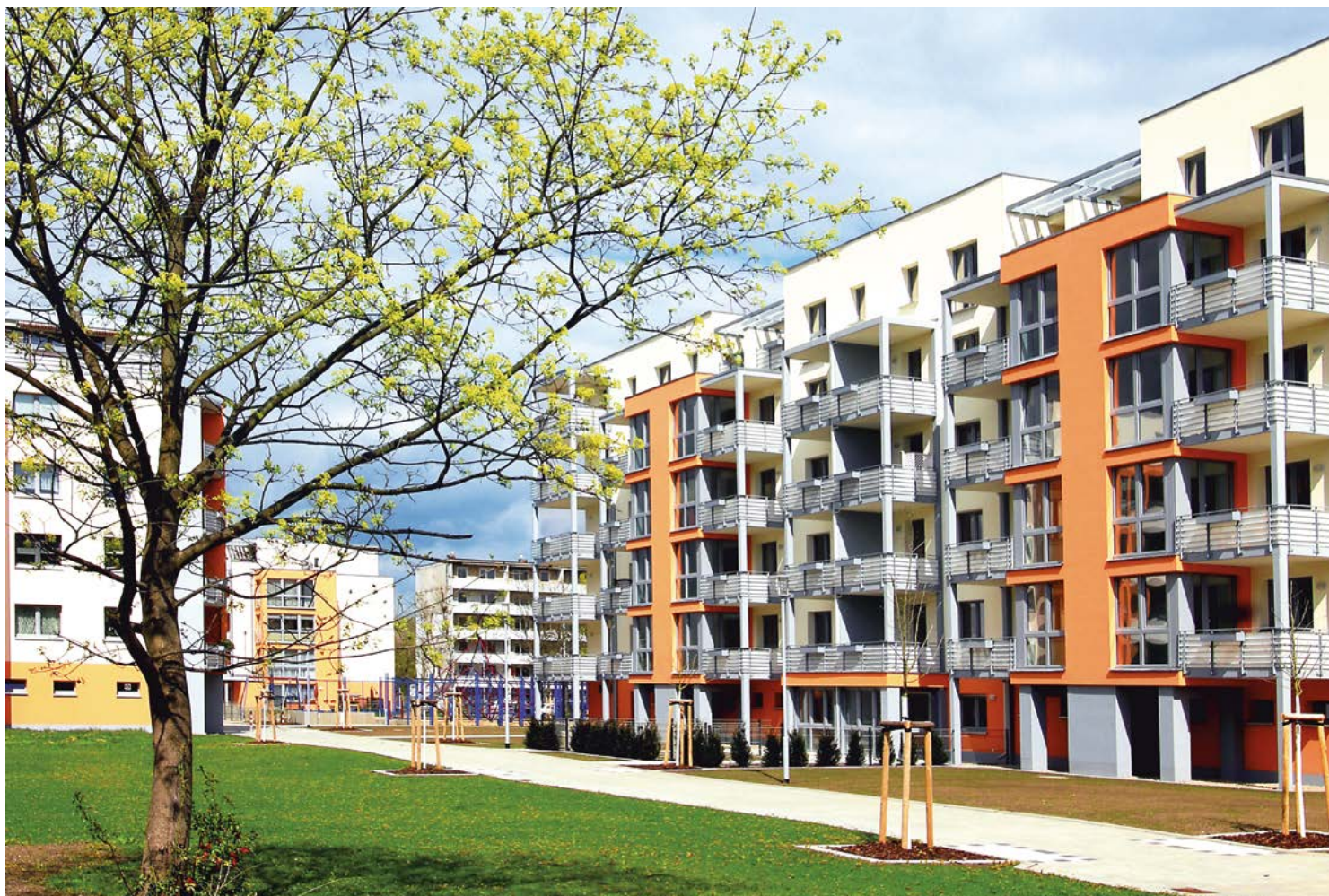
Der letzte Bauabschnitt im Glogower Ring 38 – 41 konnte fast fertiggestellt werden.
