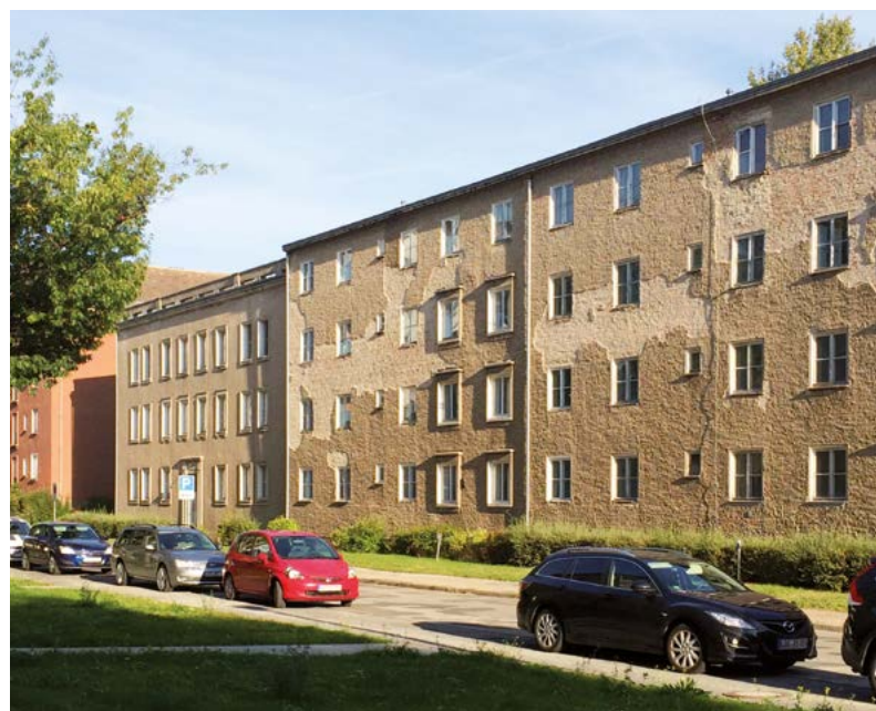
Die Modernisierung des denkmalgeschützten Wohnblocks in der Rosa-Luxemburg-Straße 14–16a beginnt.
